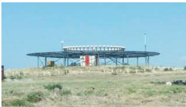
Photo du VOR/DME sur la piste de l'aéroport international Toussaint Louverture
